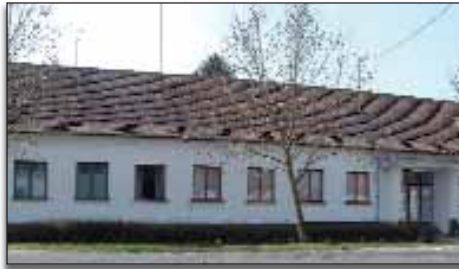
Pored sadašnjeg učeničkog doma u Santovu uskoro će se graditi nova zgrada Hrvatskog vrtića i učeničkog doma
