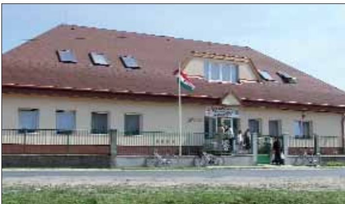
Obnova školske zgrade je začela pred osmimi ljeti
