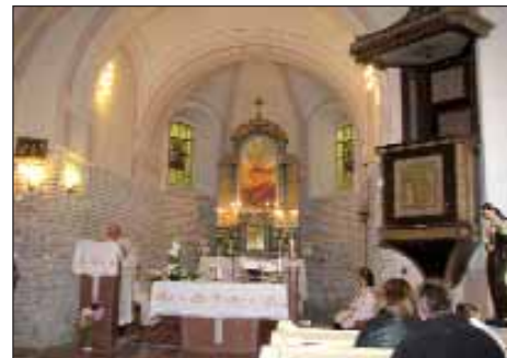
Nutarnji dio crikve je pod obnovom
