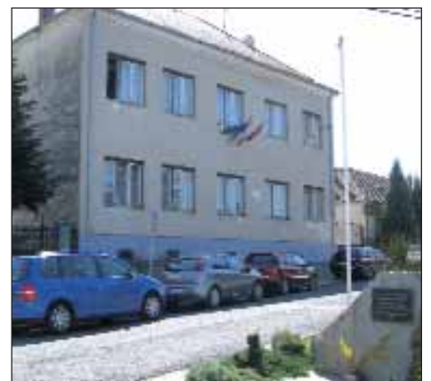
Po obećanju, do 1. septembra će biti gotova obnova školske zgrade
