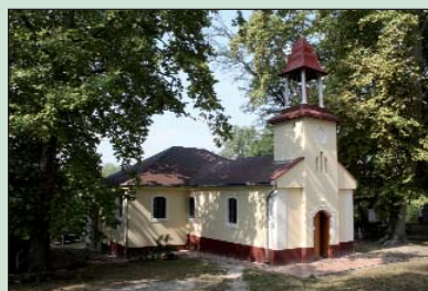
Obnovljena kapelica na bajsjoj Vodici
