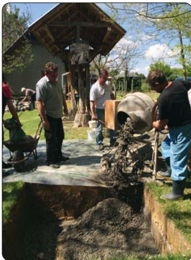
Betoniranje temelja
