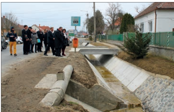
Iskopane, oblikovane i počvršćene su grabe za odvodnjavanje na 1139 metari
