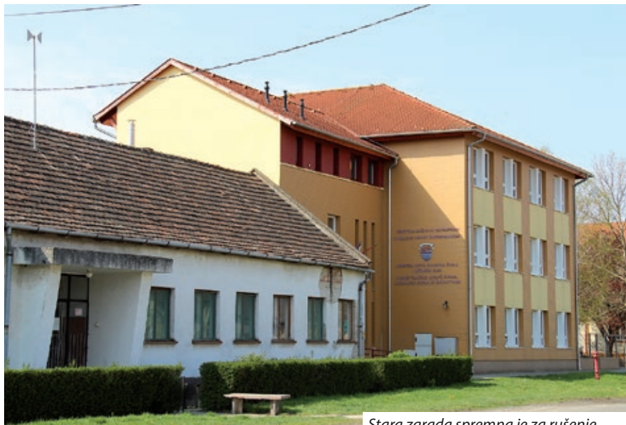
Stara zgrada spremna je za rušenje
