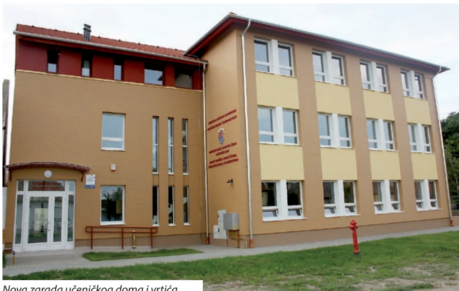
Nova zgrada učeničkog doma i vrtića
